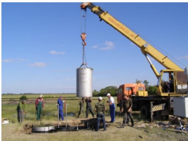
Вставка монолита в лизиметрическую станцию
