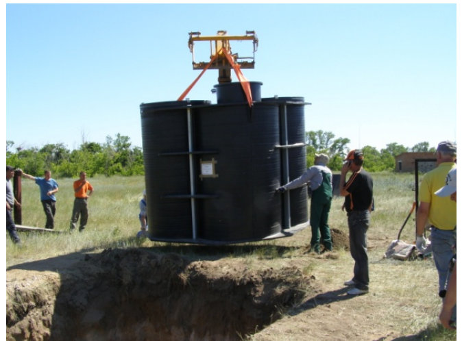
Установка лизиметра в яму
